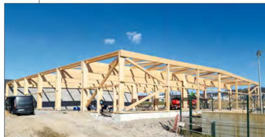
Green 7 (Salaise-sur-Sanne) se dote, sur les bâtiments de Basic Fit et Tool Station, d'une superbe charpente en bois de 50 tonnes et de murs et bardages bois de 60 tonnes (pins et mélèzes) issus de la filière bois française.
